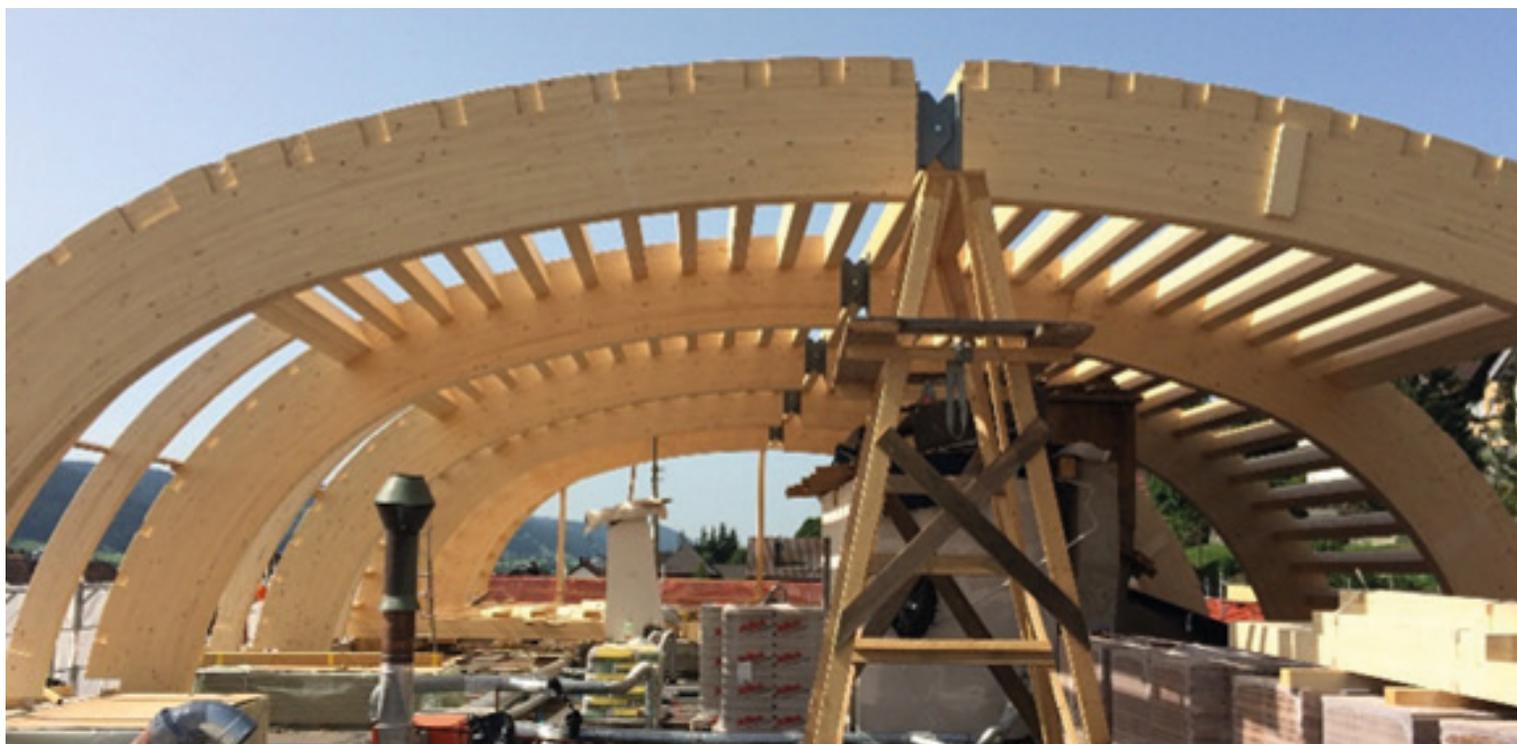
12 grands portiques en bois lamellé-collé fabriqués en deux parties avec des ferrures mécano-soudées en pied et en tête de portique ont été posés par les charpentiers.
